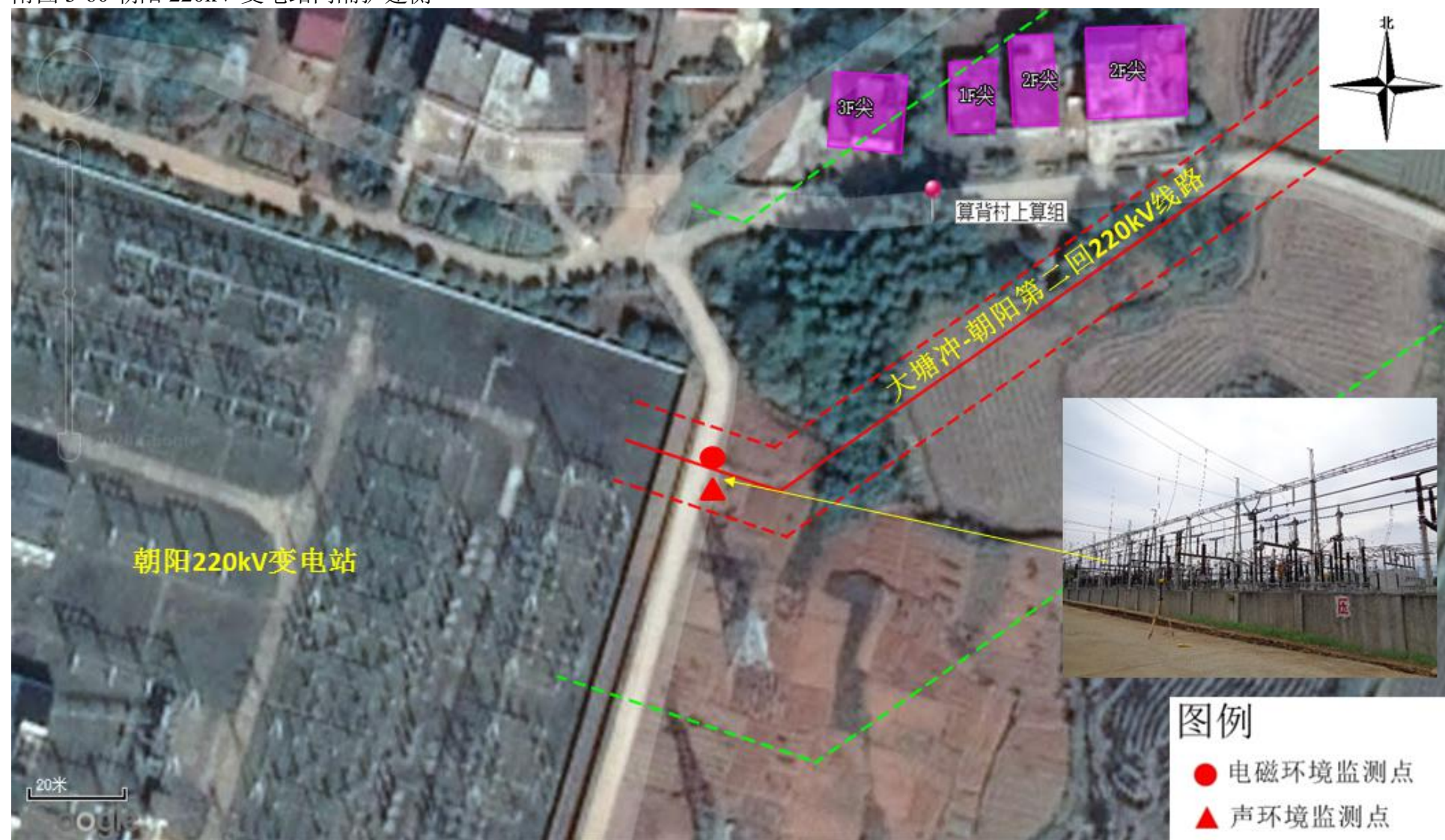
附图 3-60 朝阳 220kV 变电站间隔扩建侧
