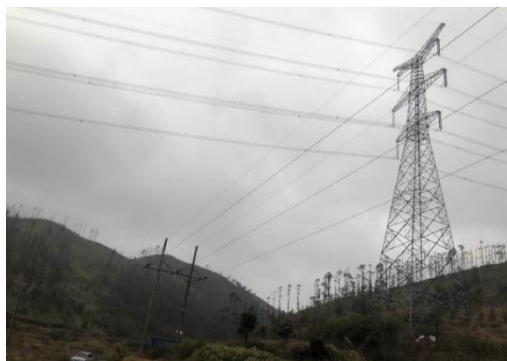
本工程已建双回路跨越 110kV 桐道线
