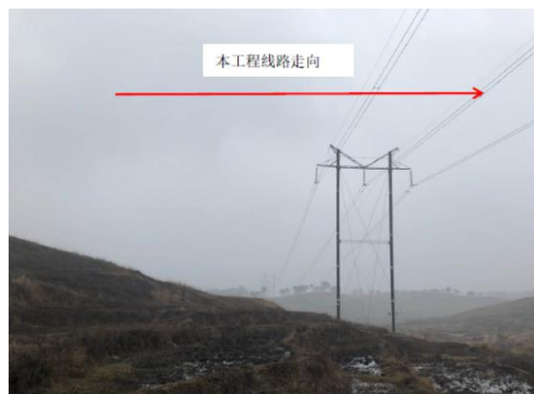
跨越 220kV 柏蒋线处
