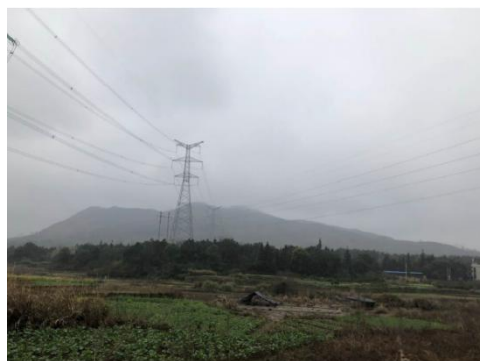
本工程已建双回路跨越 110kV 桐柑线
