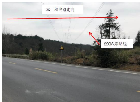
跨越 220kV 宗晒线与 S216 省道处
