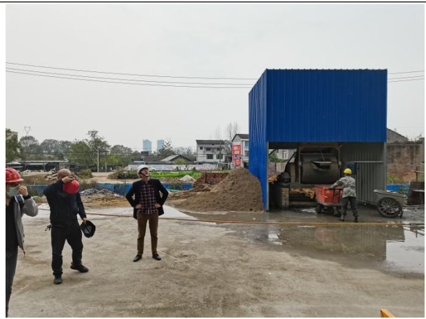
门急诊医技楼西侧
