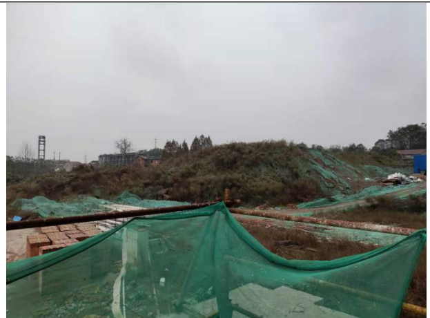
门急诊医技楼北侧
