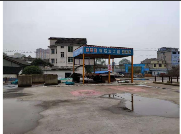
门急诊医技楼南侧
