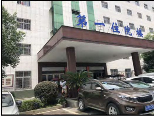
项目所在第一住院楼
