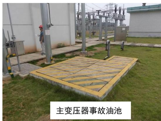
图 3-2 星城 500kV 变电站内主变压器下方卵石层及事故油池
