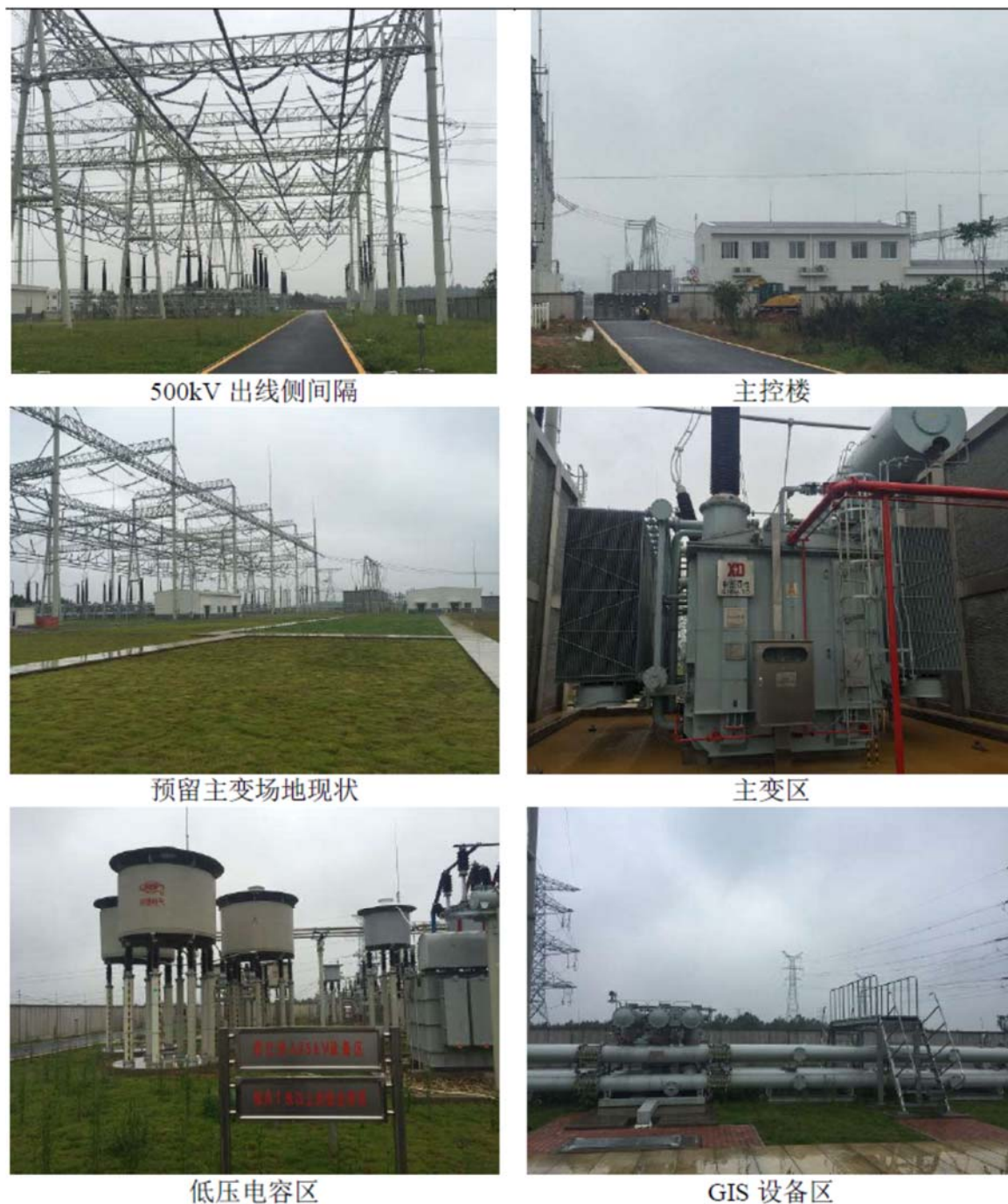
图 3-1 澧州 500kV 变电站站内情况
