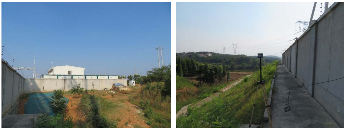
图 4-1 澧州 500kV 变电站周围环境现状
