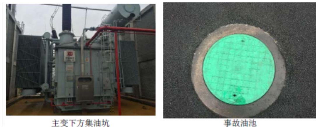
图 3-4 澧州 500kV 变电站站内现有事故油坑、油池照片
