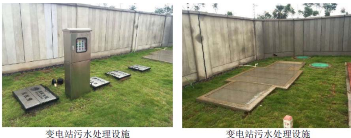
图 3-3 澧州 500kV 变电站站内污水处理设施现状照片
