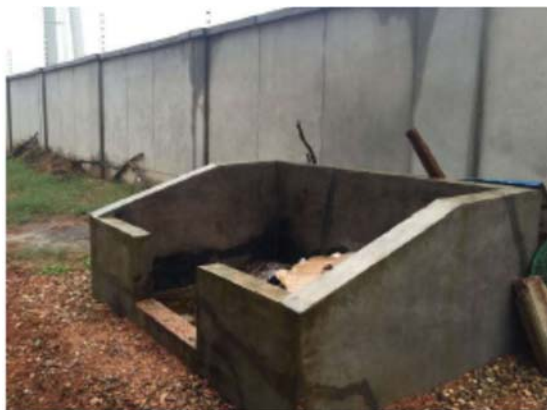
图 3-5 澧州 500kV 变电站站外垃圾收集装置
