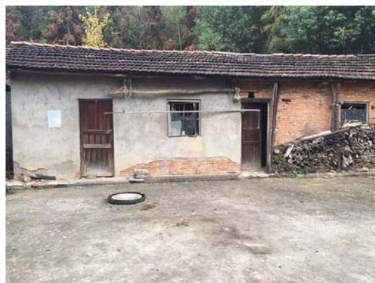
变电站北侧约150m处居民房杂物间
