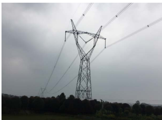
跨越500kV昆沙线
