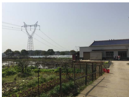
跨越500kV复沙 I 线
