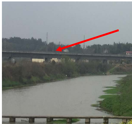
跨越京广铁路
