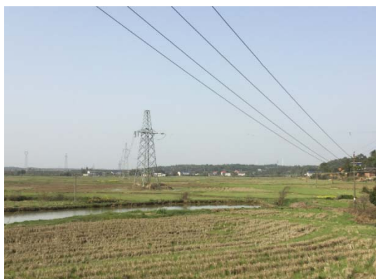
跨越韶山换流站接地极线路
