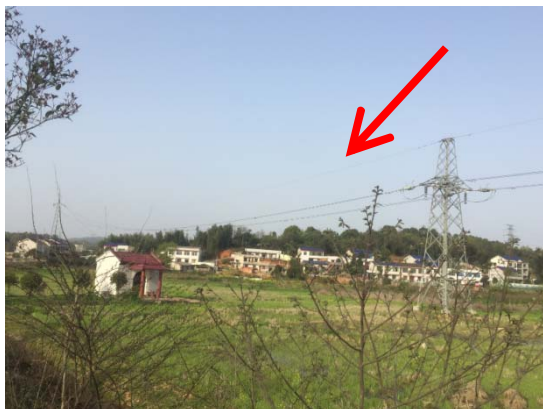
跨越韶山换流站接地极线路
