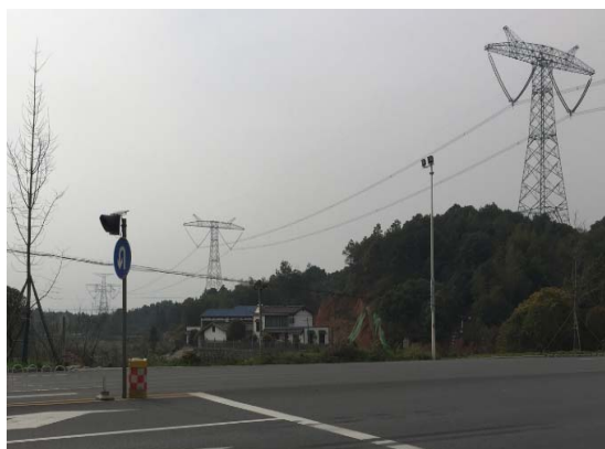
\pm 800 kV溪浙线
