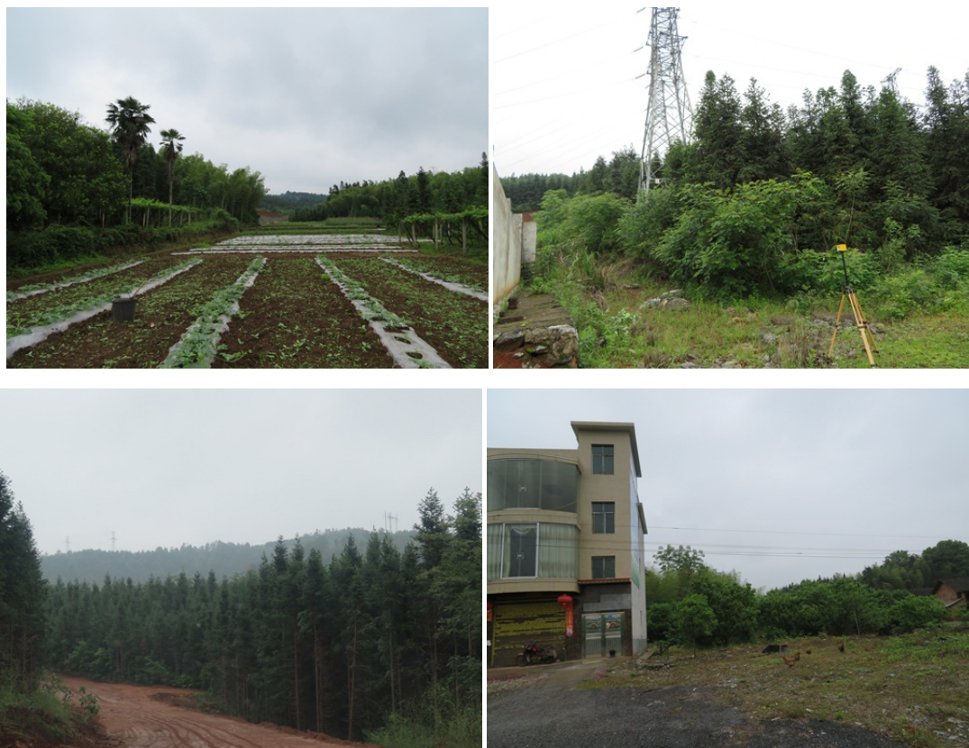
图 4-3 110kV 园华线、两华线环境现状
