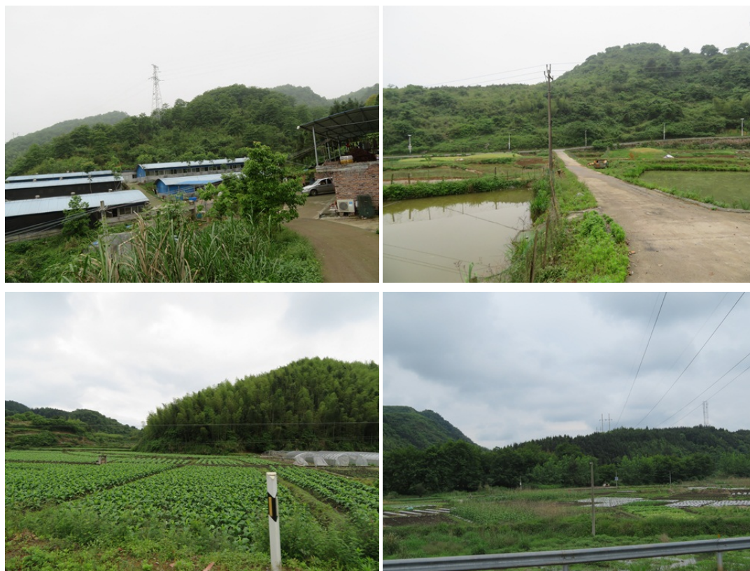
图 4-4 110kV 油坨线环境现状
