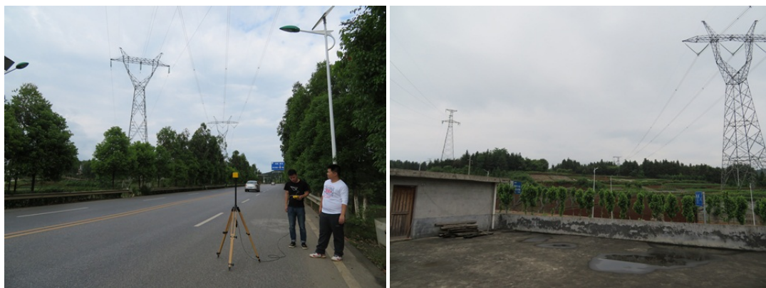
图 4-2 500kV 苏紫 I 线 008 号塔改造段环境现状
