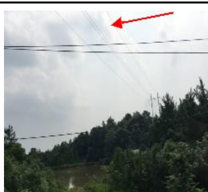
图 1-3 跨 110kV 沧牧泉线
