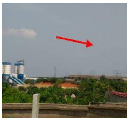
图 1-7 跨东建混凝土公司
