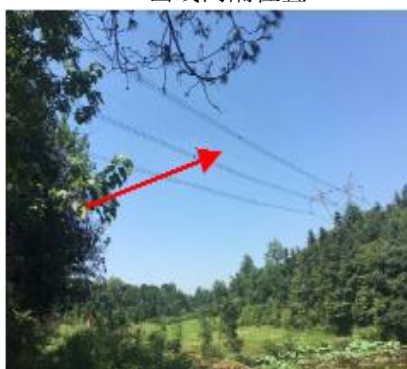
图 1-4 I 回钻 500kV 复沙 II 线处
