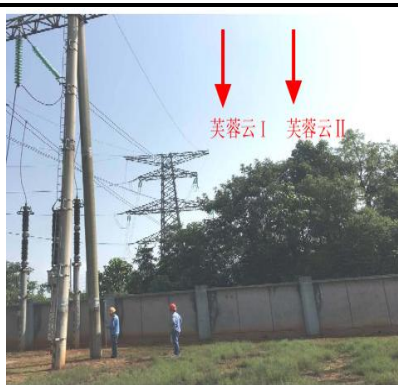
图 1-1 沧水铺 220kV 变 220kV 出线间隔位置
