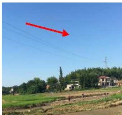
图 1-5 跨 110kV 沧泉线
