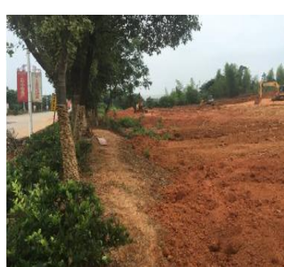
图 1-9 在建的芙蓉云 220kV 专用变
