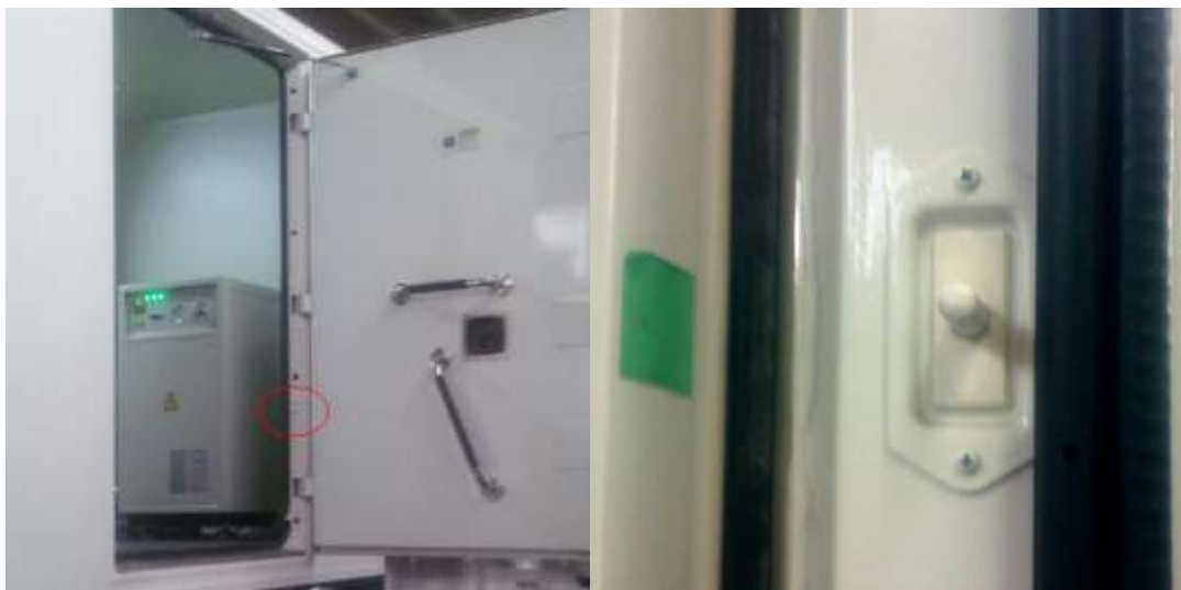
图 10-6 门联锁（右图为左图红圈内物体的放大图像）
