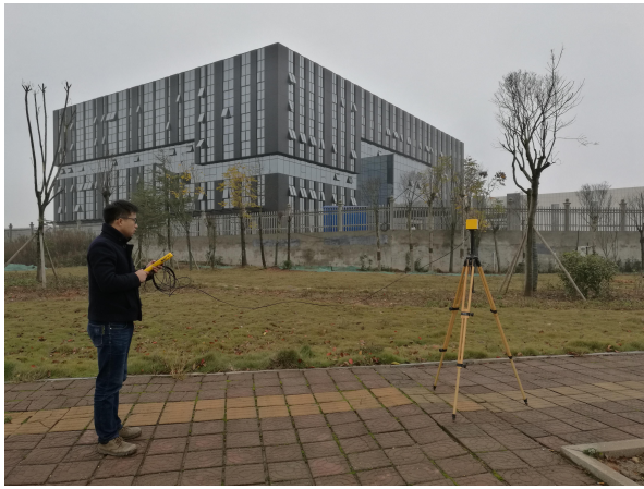
吉利西路与保税路交叉口东南角现场监测
