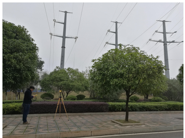
220kV 九华变电站南面现场监测
