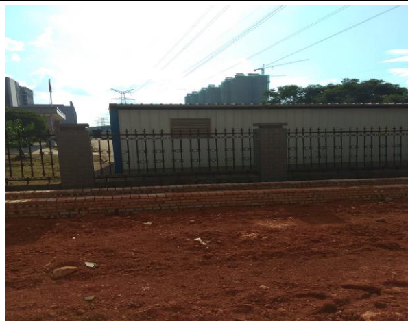
照片 4 探伤室所在厂房外东侧
