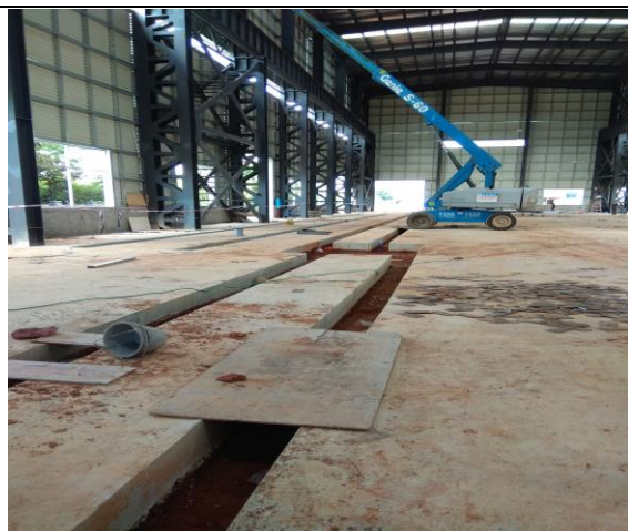
照片 1 探伤室外西侧厂房工作区
