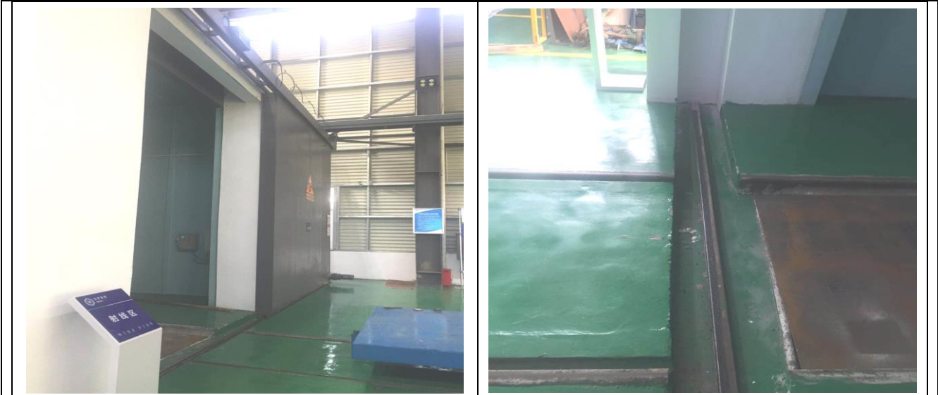
照片 5 工件地轨及探伤室门地轨连接处
