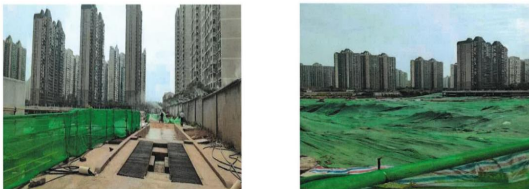
图 5 施工场地现场整改情况
