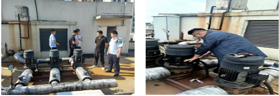
图 10 执法部门现场核实（左）、设备维修现场（右）
