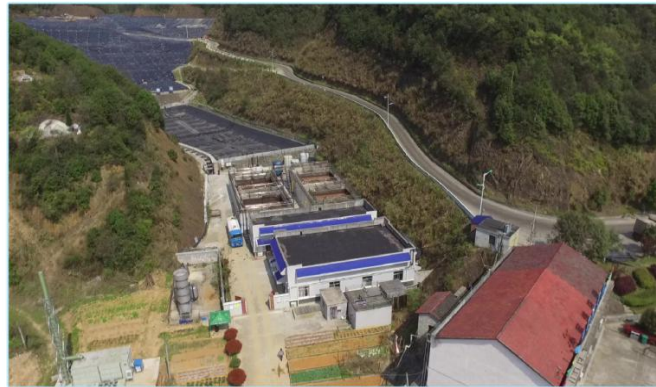
污水处理和填埋场
