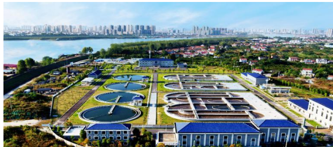
皇木关水厂航拍图
