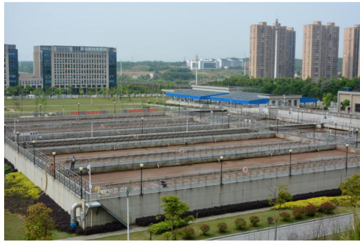
图 2. 雨花水质净化厂生物池
