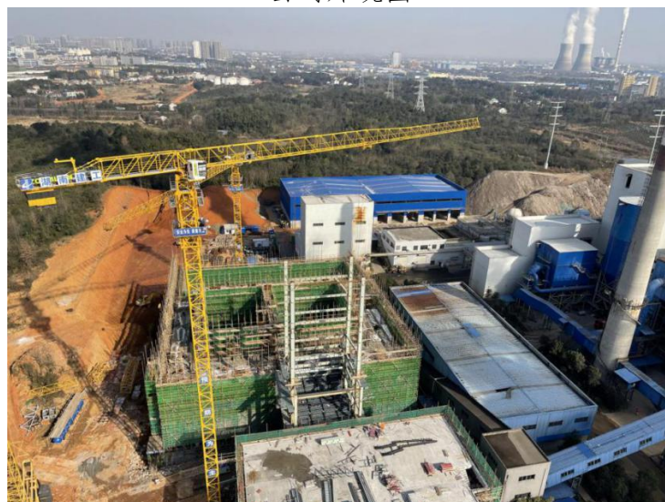
公司三期置换项目施工现场
