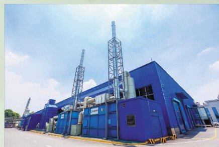
废水处理系统
