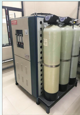
电解法二氧化氯复合消毒剂发生器
